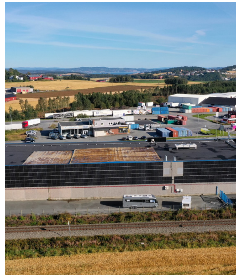
Solcelleanlegget hos Nær Engros Levanger (Foto: NTE)
